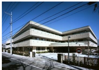
▲すだちの里すぎなみ外観
